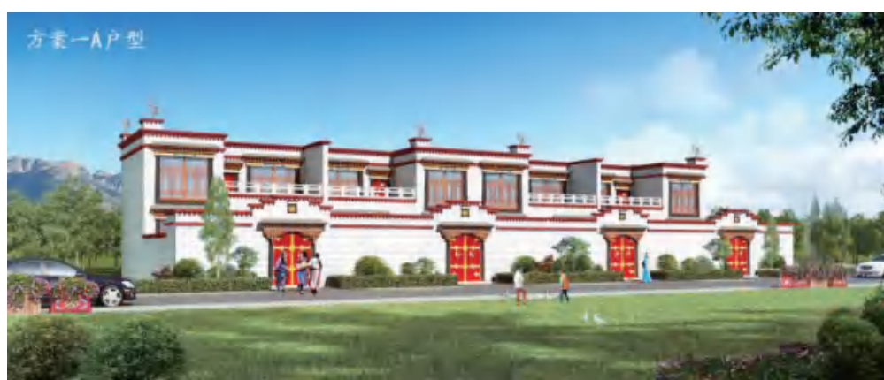
拉萨建设尼木县小康安居集中搬迁点建设项目,位于西藏自治区拉萨市尼木县,总建筑面积 13965.85 m 2 。目前完成 25 栋住宅(86 户)及配套附属设施总体工程的现场临建、围挡、临时水电、道路平整建设;9 栋住宅(33 户)基础工程、主体工程、水电预埋全部完成。高品质的改善型小康式居住小区,不仅更好地服务城市新区,也提升了尼木县的聚集能力。
